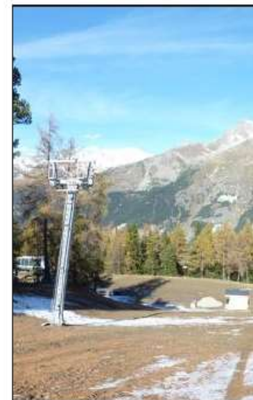
Le télésiégi des Granges au moment de sa construction : c'est d'un appareil moderne à enrouleurs, datant de 2012.
